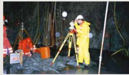
Grâce aux géomètres, les ouvrages sont érigés exactement à l'endroit prévu. (Photo René Haag)
